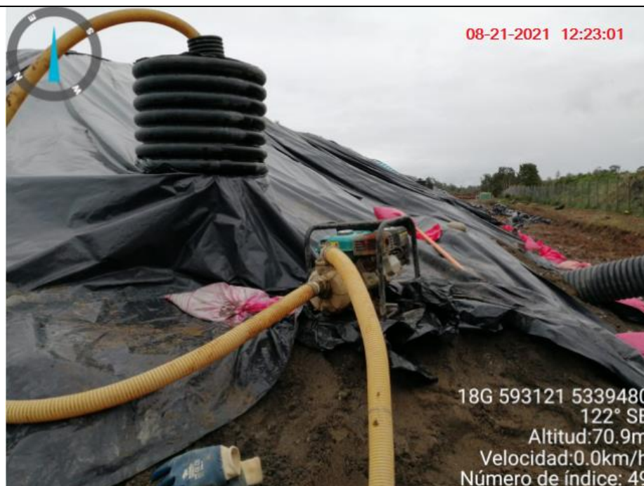
Fotografía N°3: Retiro de Lixiviados desde cámaras C8, por Empresa Crecer y Personal Municipal. Tomada: Sábado 21 de Agosto del 2021.
