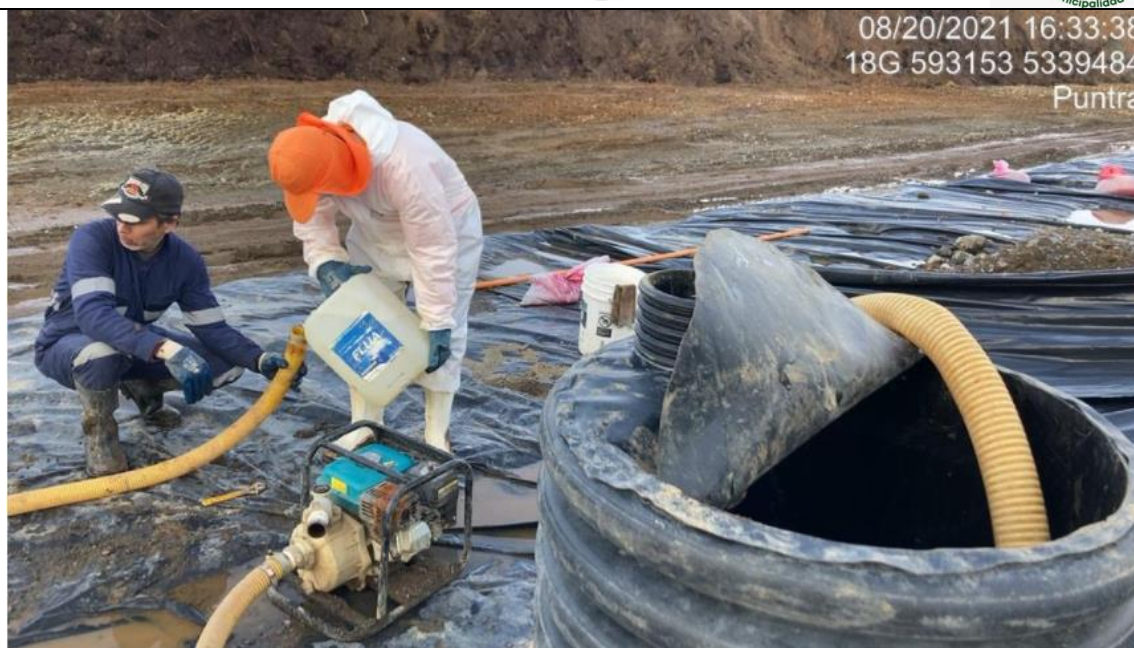
Fotografía N°2: Retiro de Lixiviados de cámaras de inspección de sobrecelda, por Empresa Crecer y Personal Municipal. Tomada: Viernes 20 de Agosto del 2021.
